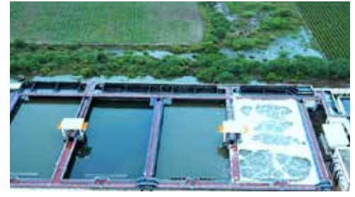
32.3 MLD STP, Surendra Nagar, Gujarat
