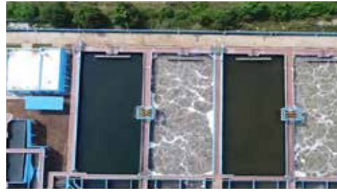
33 MLD STP, Anand, Gujarat
