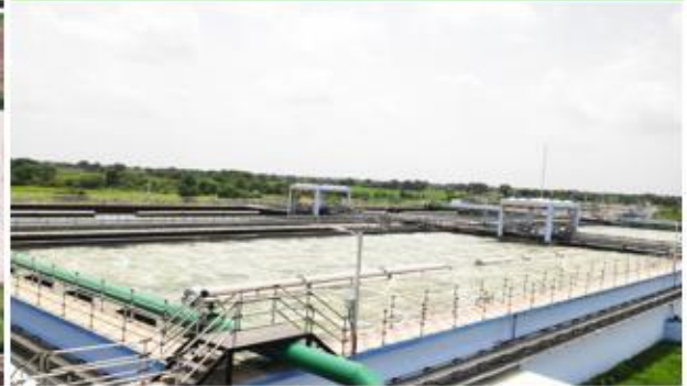
32 MLD STP Botad Gujarat
