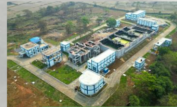
17.05 MLD STP ,NRDA
