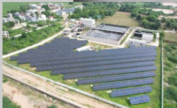
30 MLD STP, Kota
