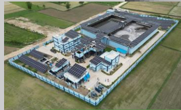
20 MLD STP, Bareilly
