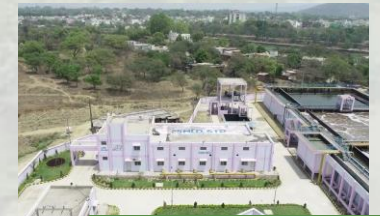
25 MLD STP, Raigarh
