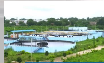
18.46 MLD STP, Mehsana
