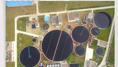
21 MLD CETP, Panipat
